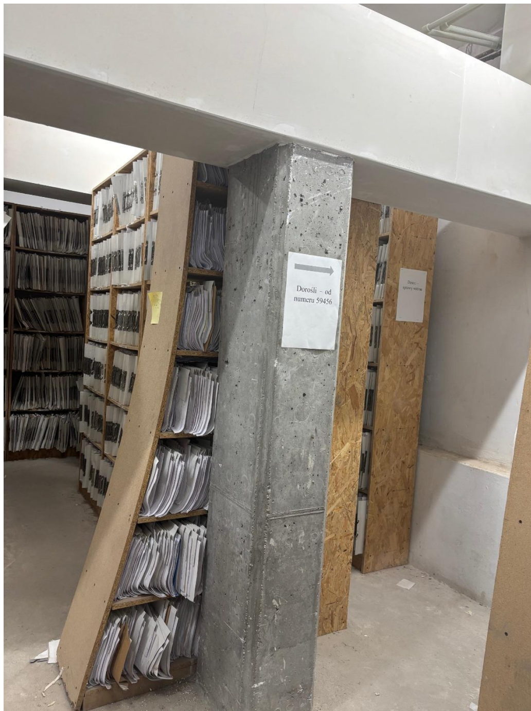
Nr 4: Pomieszczenie nr 2:
