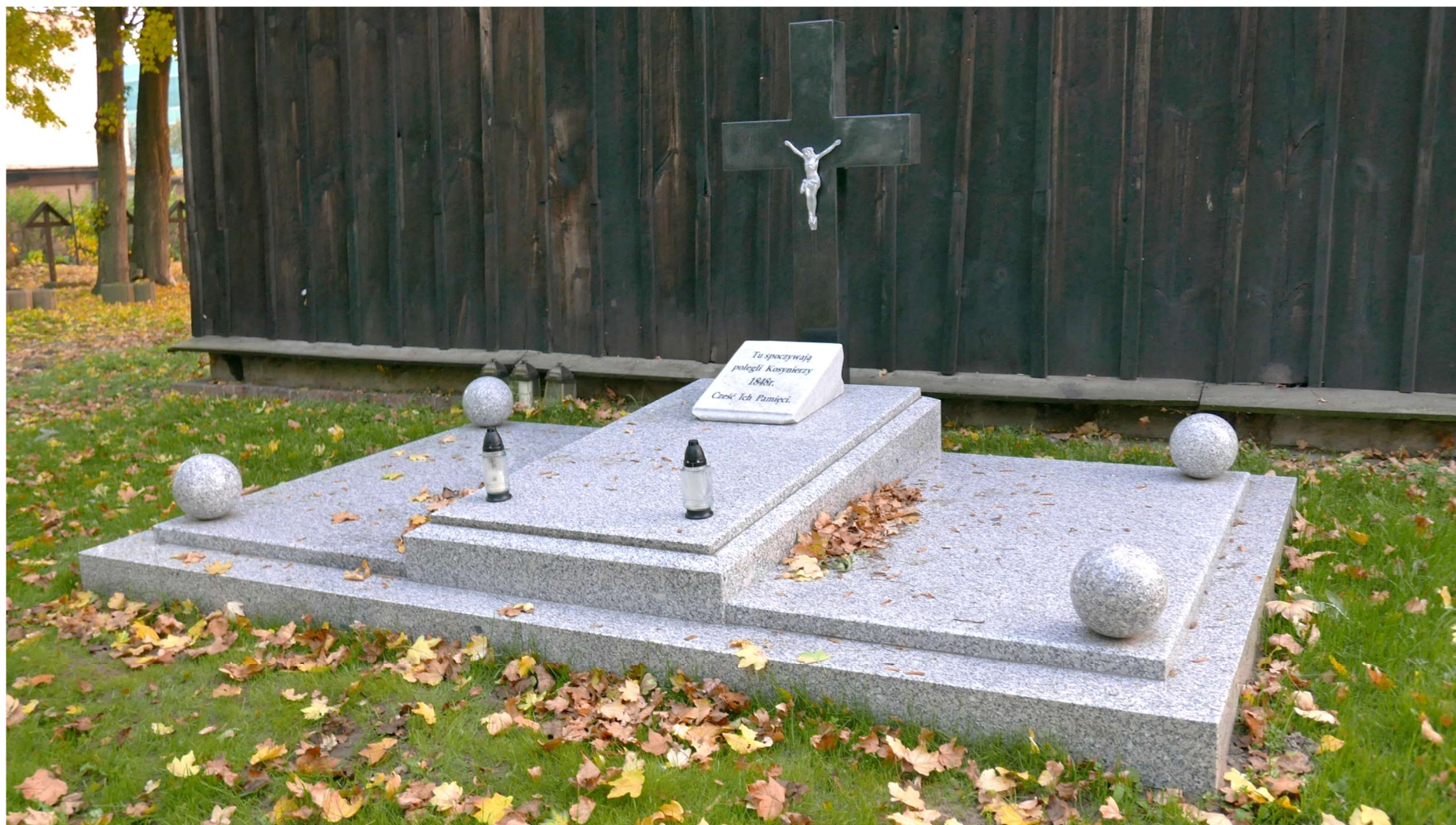
Grób zbiorowy po remoncie:
