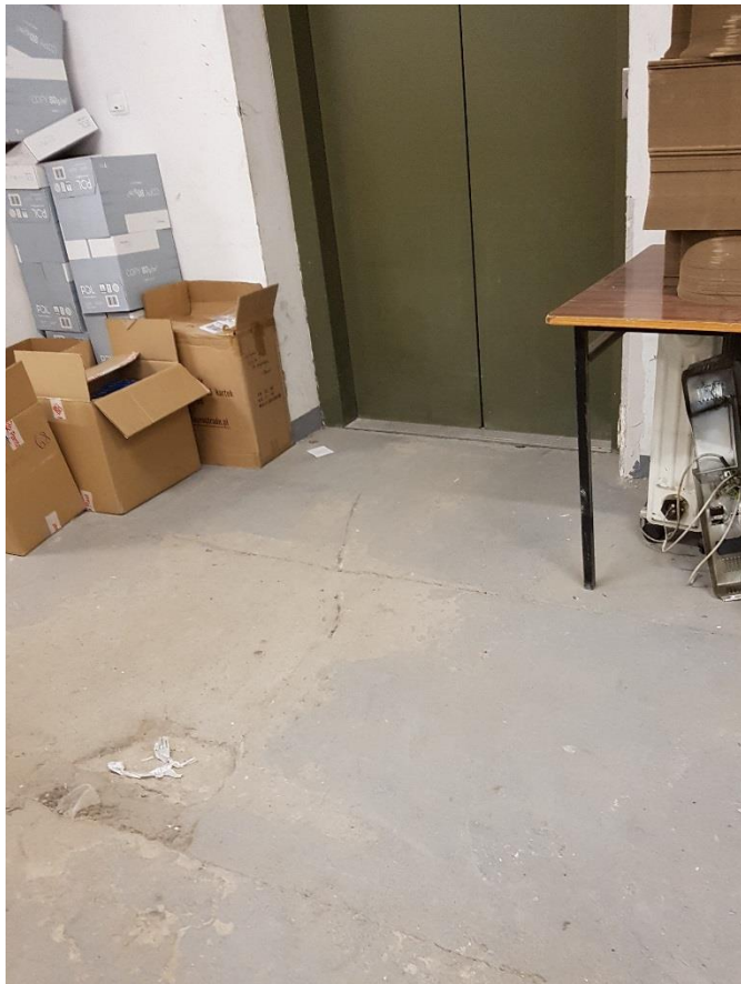
Zdj.4 Podjazd na poziomie -2
