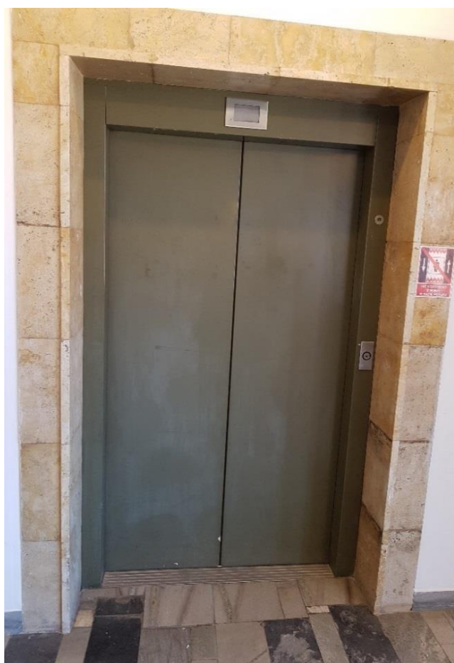
Zdj.2 Drzwi na 5 piętrze – widok ogólny
