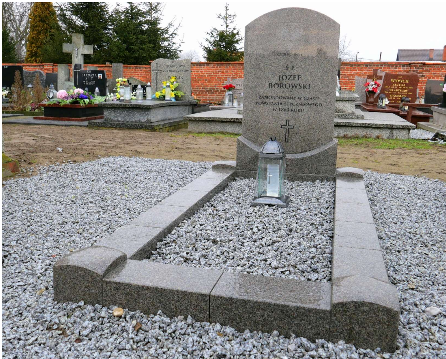
Grób po remoncie:
